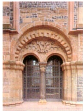
Heidenportal am Wetzlarer Dom
